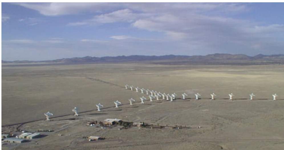
Vista aérea del Gran Arreglo de Antenas (VLA, sigla en inglés) mirando hacia el norte-noroeste. Este complejo de grandes radiotelescopios se utiliza con el propósito de hacer una gran cantidad de estudios astronómicos, incluyendo búsquedas de vida extraterrestre (SETI) Aquí las antenas están en su configuración más cercana (configuración D), Fotografía: Dave Finley: Cortesía NRAO/AUI
